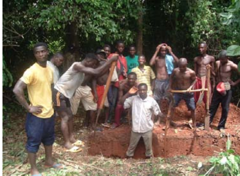
WC de fortune en construction
