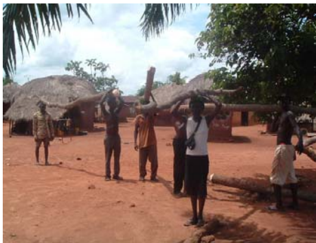
Les travaux de construction de l'appatame
