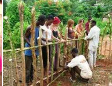
Construction de l'unité porcine
